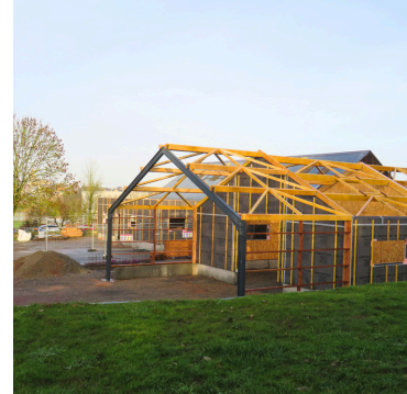
Lancement des travaux à l'ESAT du Louroux-Béconnais L'Argerie
