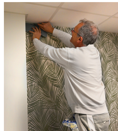
Travaux de second œuvre
